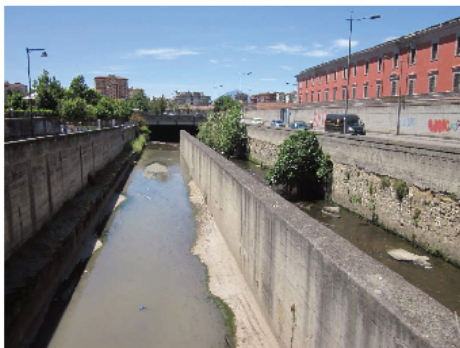
Imm.3 A sinistra il torrente Cavaiola e a destra il torrente Solofrana, nella zona di confluenza nel canale Nocerino.
